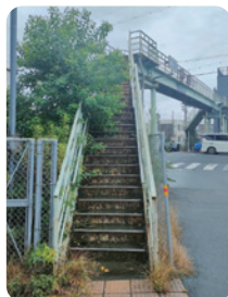
樹木が生い茂っていた歩道橋
